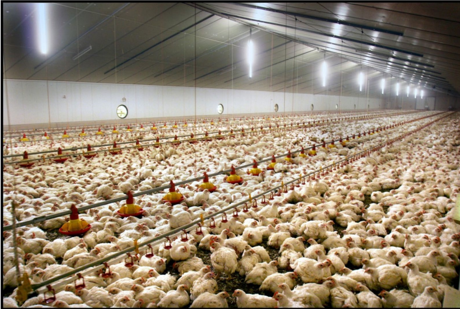
In nieuwe kippenstallen worden luchtwassers geïnstalleerd. — © Maarten Hartman
